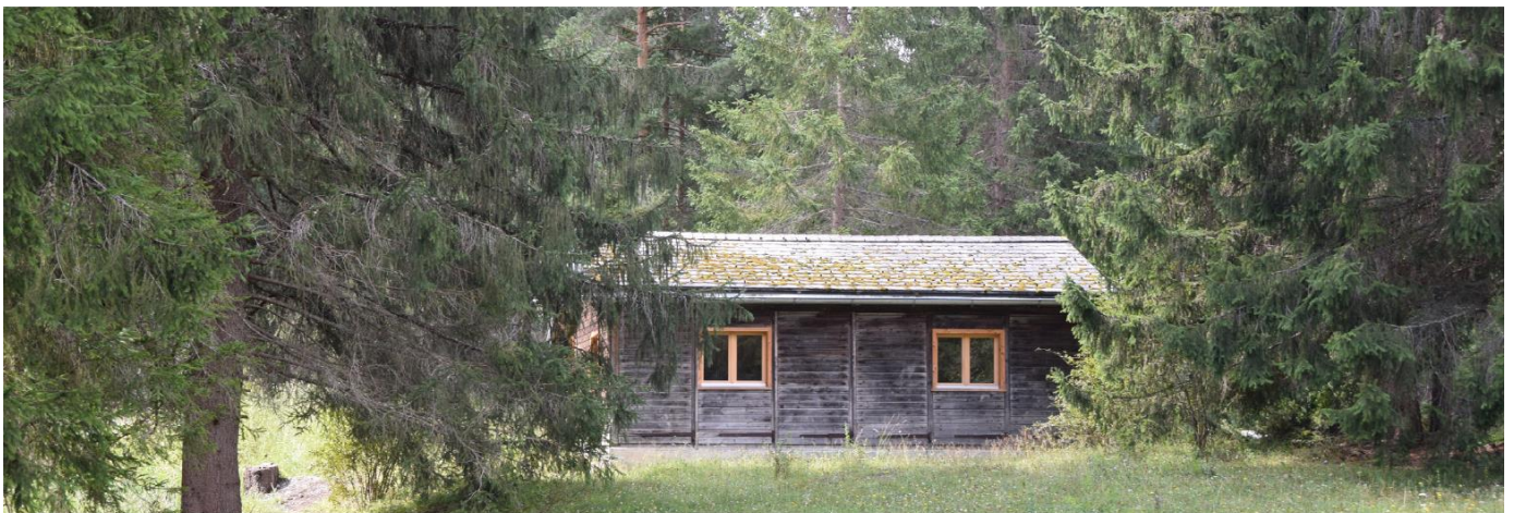
la chasina da trar a Panas-ch | ehemaliges Schützenhaus in Panas-ch
